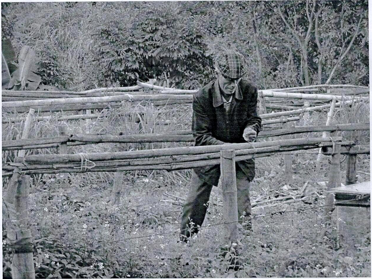
Trên đây là hình ảnh giàn phơi miến bằng tre nứa sau 1 năm là lại mục nát phải thay hặc gia cố buộc thêm.
